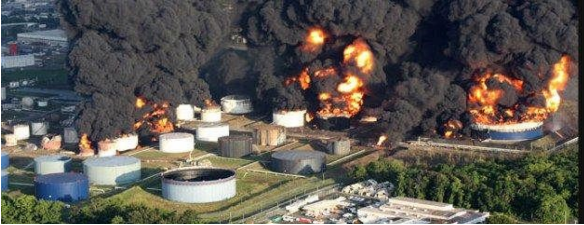
Une explosion très puissante au Caribbean Petroleum Corp le 24 Octobre 2009.
